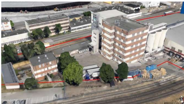
Rysunek 37 Budynki tłuszczarni ryżu (Google Earth)
