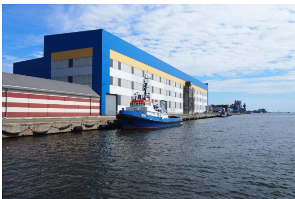
Rysunek 57 Budynek Vistal Offshore przy nabrzeżu Indyjskim (fot. Ekovert)
